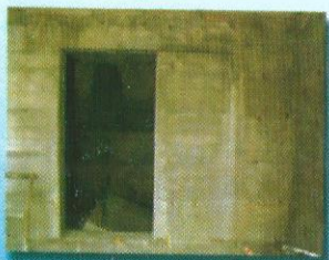
CORTE DE MURO DE HORMIGON
